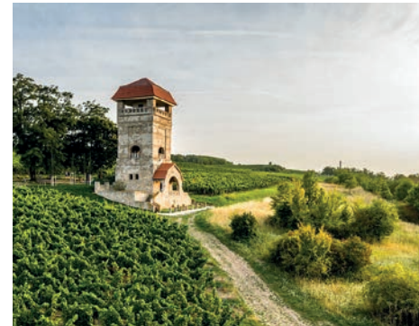
Früher Wasserwerk, heute Aussichtsturm
